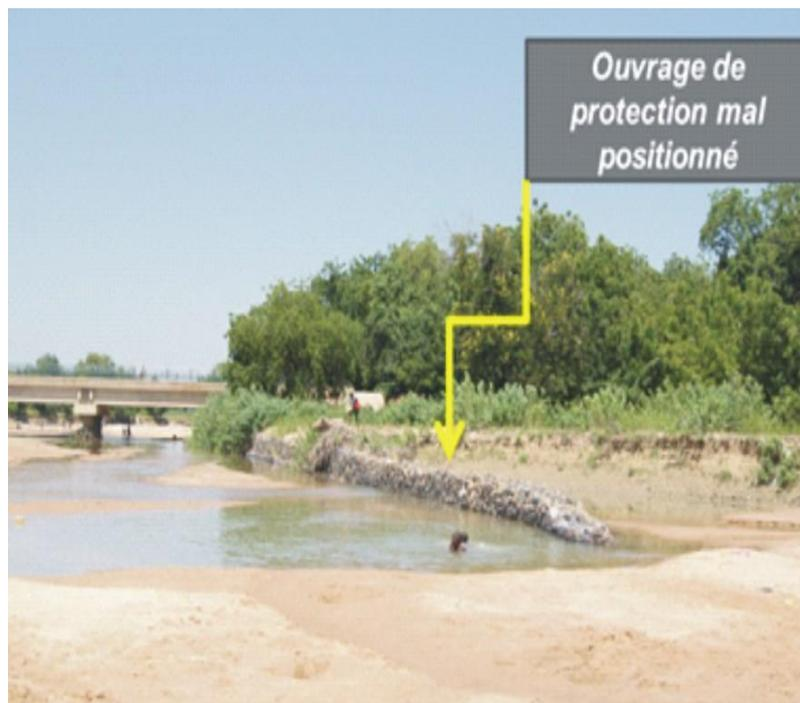
**Photo 4 :** *Ouvrage de protection dans la zone de Maga*
