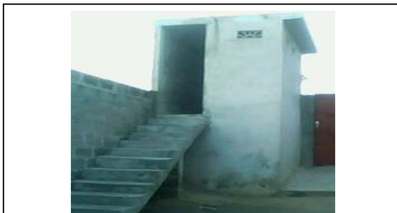
Photo 3 : Latrine construite en hauteur à Gbôdjê avec les réceptacles au-dessus du niveau du sol.
