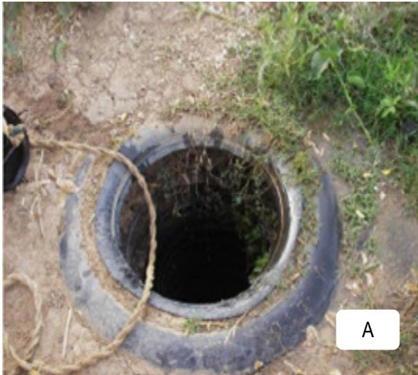
**Figure 2 :** Puisard protégé par des pneus au quartier Boulmiougou de Ouagadougou
