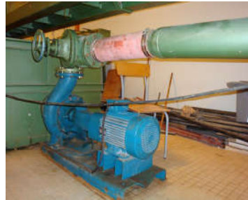
Photo5 : vanne de réglage et pompe
