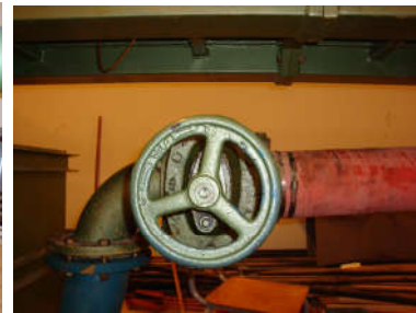
Photo5 : vanne de réglage et pompe
