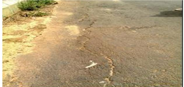
Plate 4: Longitudinal Crack (Chainage 3+050 - 3+100)
