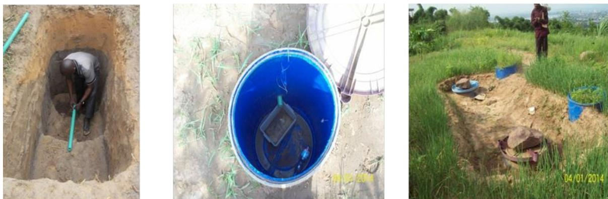
**Figure 1.** Construction des lysimètres
